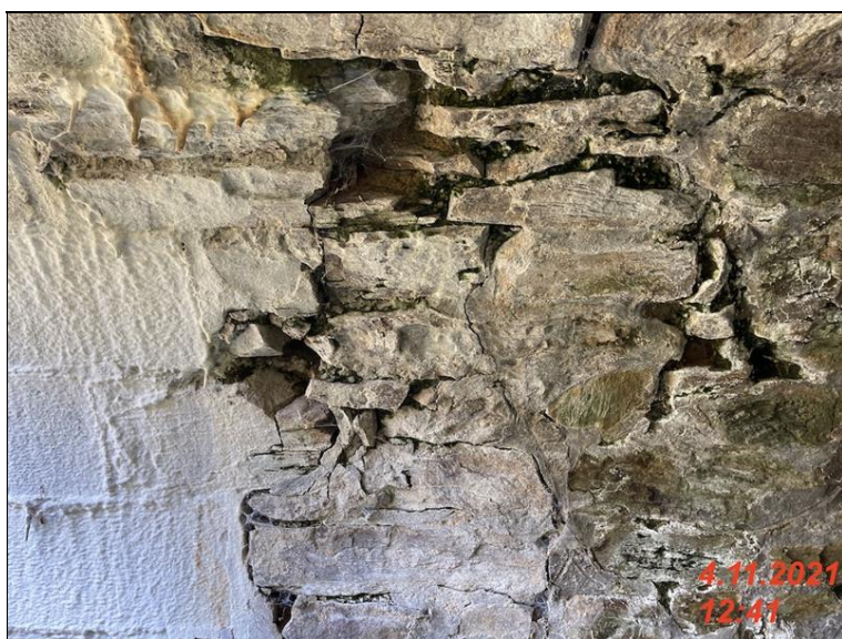
IMG_2180 - degradovana cast zdiva na podhledu NK vpravo cela prava cast je odrzena .jpg
