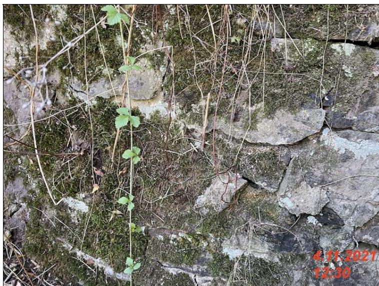
IMG_2144 - zdivo kridla K3 ma porusene sparovani zdivo je rozvolnene misty vysunute az o 50mm.jpg
