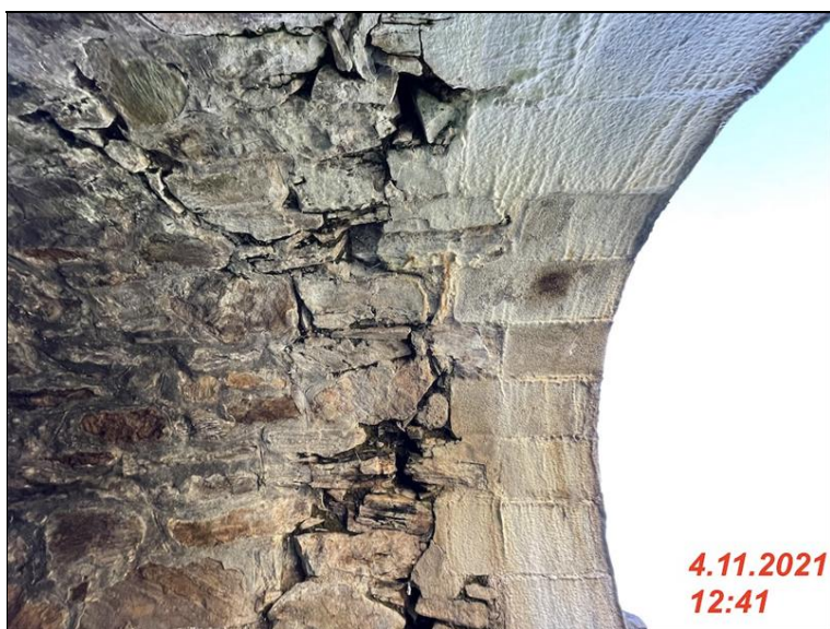
IMG_2185 - degradovana cast zdiva na podhledu NK vpravo cela prava cast je odrzena .jpg
