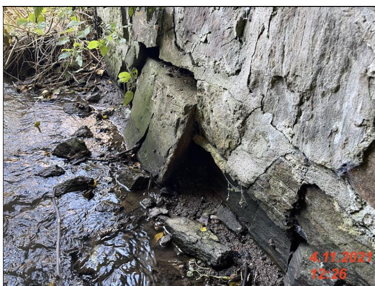
IMG_2129 - znamky castecneho podemelti opory O1 vpravo.jpg
