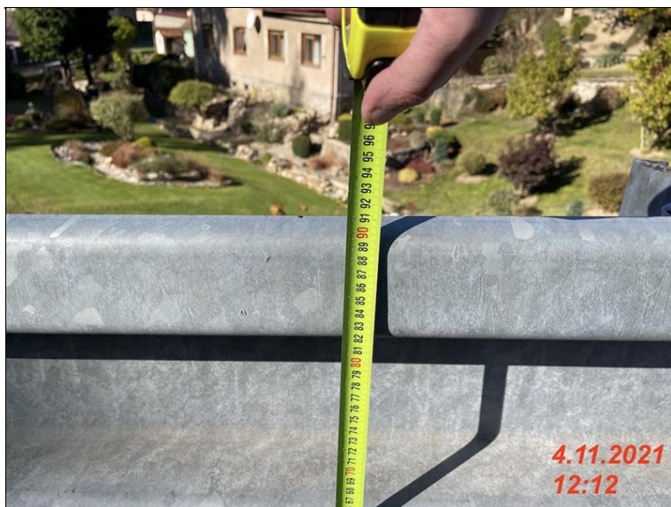
IMG_2090 - sirka krajnice na konci objektu vpravo a tím i vysokove osazeni svodidla 900mm nesplnuji normove pozadavky.jpg
