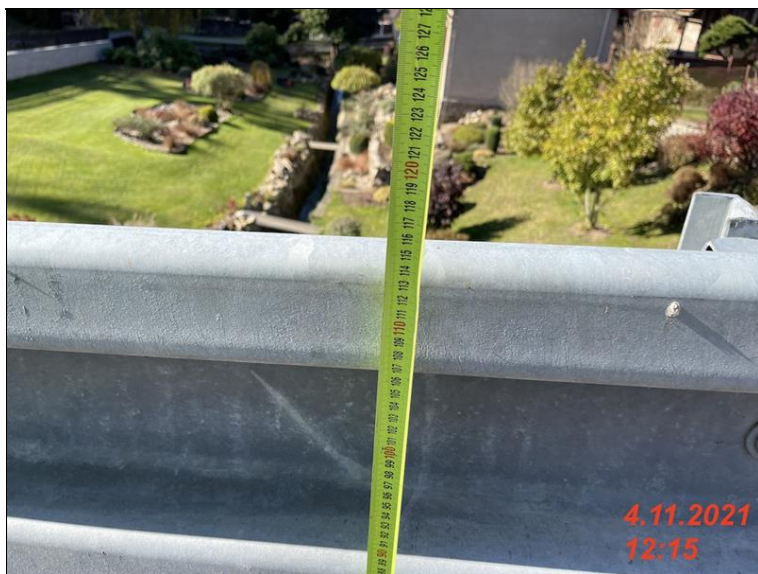
IMG_2096 - sirka krajnice na zacatku objektu vpravo a tim i vyskove osazeni svodidla 1150mm nesplnuji normove pozadavky.jpg
