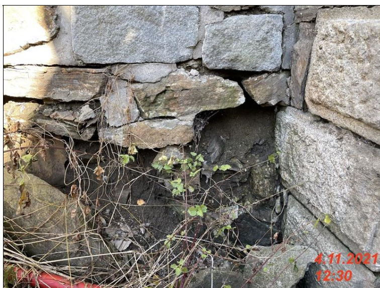
IMG_2138 - vypadla cast zdiva ve spodni casti kridla K2.jpg
