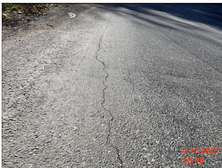
IMG_2076 - lokalni trhliny vozovky spise na konci objektu vpravo.jpg
