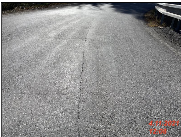
IMG_2072 - otvorená trhlinapracovní spára v ose komunikace.jpg
