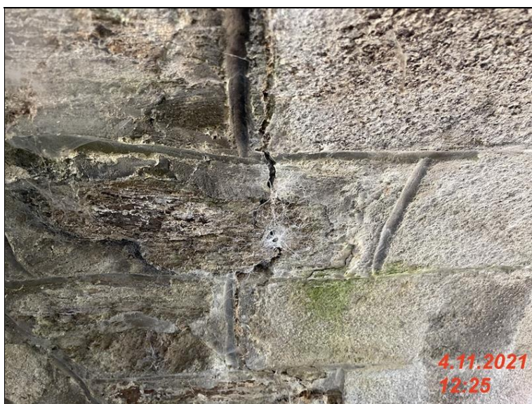
IMG_2120 - cca 700mm zleva je na opere O1 trhlina sire az 5mm.jpg
