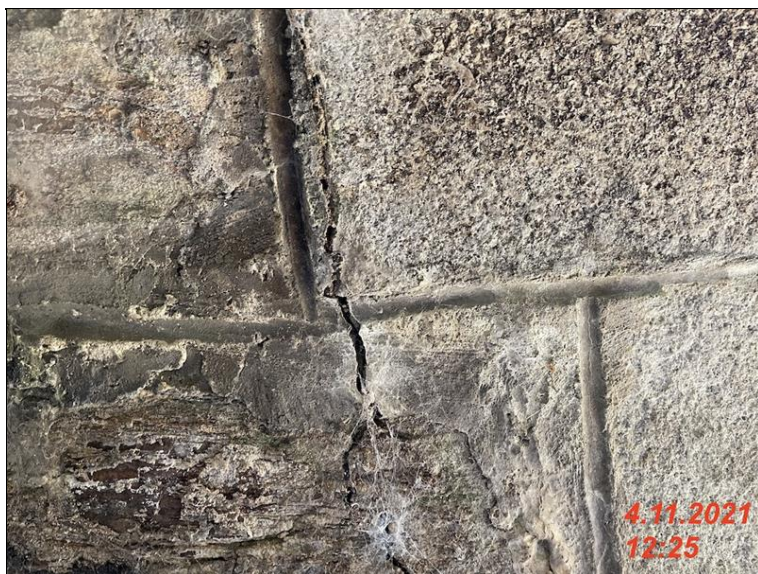
IMG_2121 - cca 700mm zleva je na opere O1 trhlina sire az 5mm.jpg
