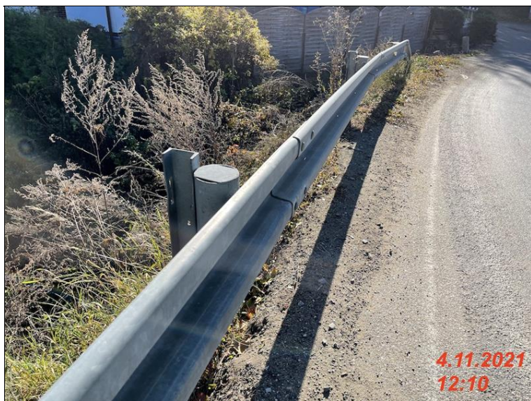
IMG_2081 - leve svodidlo je mírně deformované_ok.jpg
