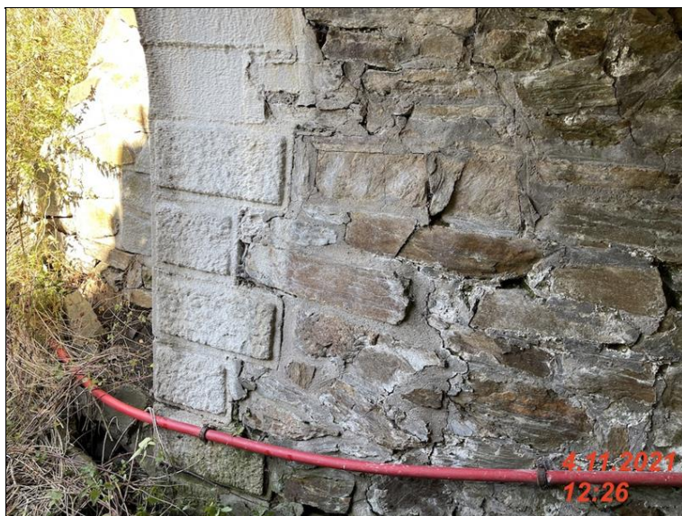
IMG_2131 - cca 600mm zprava je na opere O1 trhlina sire az 5mm.jpg
