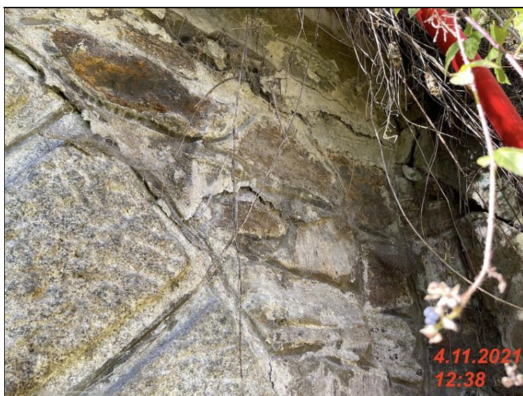
IMG_2169 - částečně odtržena část levé cekni zdi od NK.jpg
