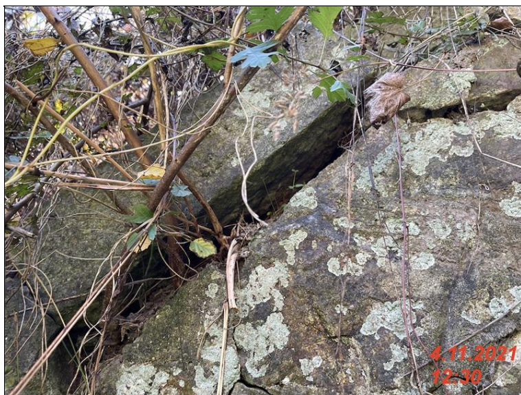
IMG_2143 - v konstrukci kridla K3 je uchycena drevina.jpg
