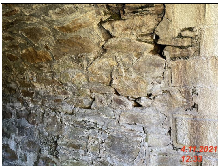
IMG_2154 - cela prava strana konstrukce opery i NK je odtrzena.jpg
