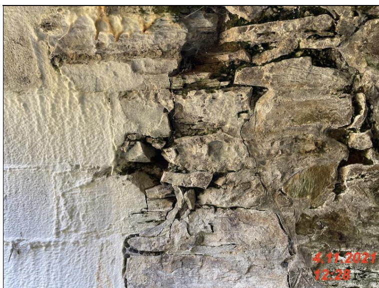
IMG_2133 - degradovana cast zdiva na podhledu NK vpravo cela prava cast je odrzena .jpg
