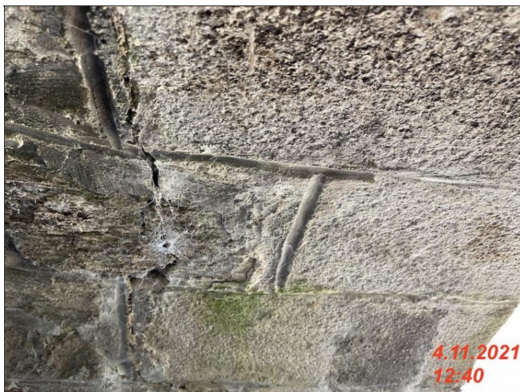
IMG_2172 - trlina cca 600mm od leveho okraje na podhledu nosne kostrukce sire cca 4mm.jpg
