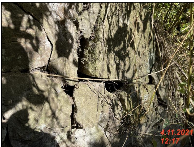
IMG_2110 - zdivo kridla K1 ma porusene sparovani zdivo je rozvolnene misty vysunute az o 50mm.jpg
