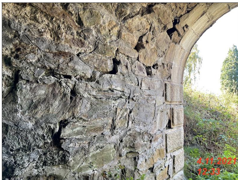
IMG_2155 - cela prava strana konstrukce opery i NK je odtrzena.jpg
