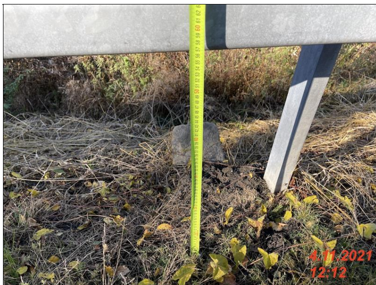
IMG_2089 - sirka krajnice na konci objektu vpravo a tím i vysokove osazeni svodidla 900mm nesplnuji normove pozadavky.jpg
