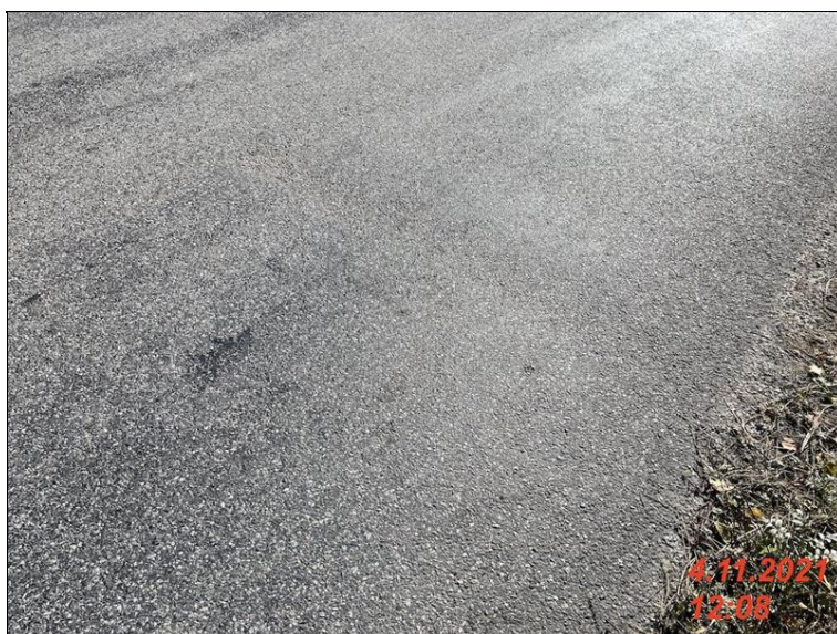
IMG_2067 - mirne pricke prosedla vozovka na zacatku objektu vpravo.jpg
