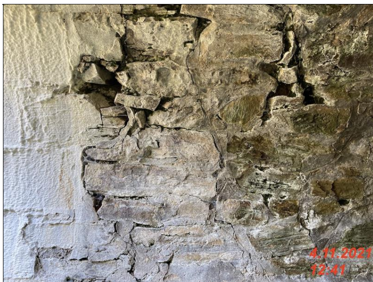
IMG_2181 - degradovana cast zdiva na podhledu NK vpravo cela prava cast je odrzena .jpg
