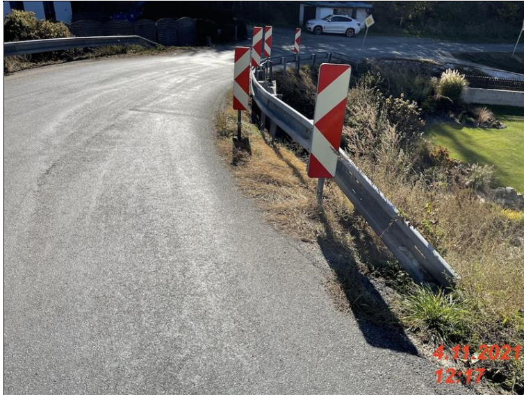
IMG_2102 - vpravo zcela chybi krajnice.jpg
