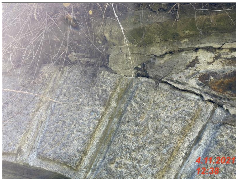
IMG_2168 - částečně odtržena část levé cekni zdi od NK vysunuti cca 20mm.jpg
