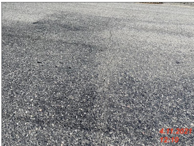
IMG_2077 - lokálni trhliny vozovky spíše na konci objektu vpravo.jpg
