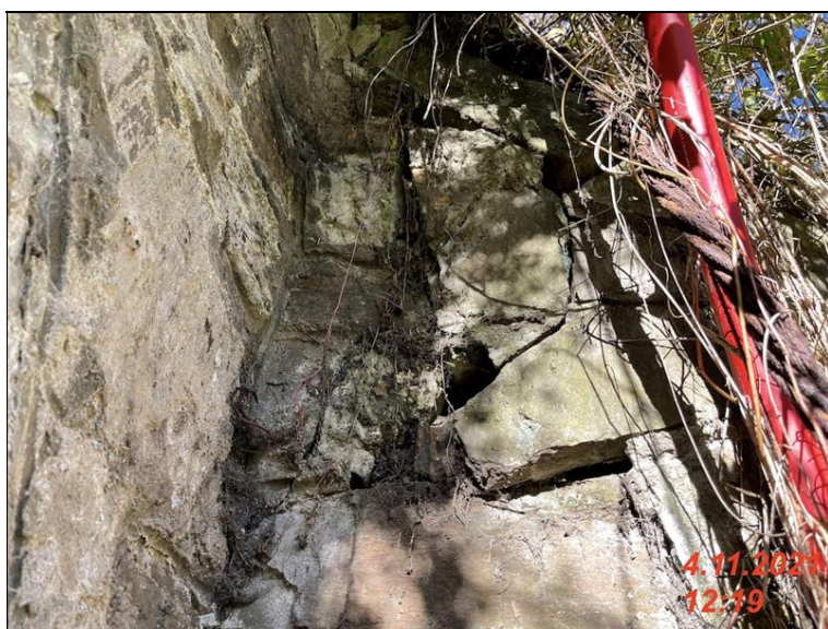
IMG_2113 - zdivo kridla K1 ma porusene sparovani zdivo je rozvolnene misty vysunute az o 50mm.jpg
