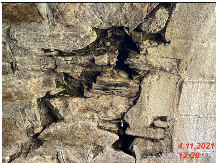
IMG_2135 - degradovana cast zdiva na podhledu NK vpravo cela prava cast je odrzena .jpg
