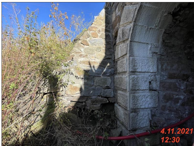
IMG_2137 - vypadla cast zdiva ve spodni casti kridla K2.jpg
