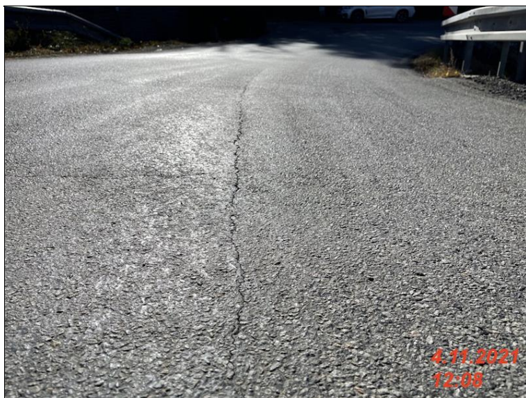
IMG_2073 - otevrena trhlinapracovni spara v ose komunikace.jpg
