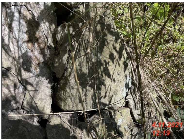
IMG_2111 - zdivo kridla K1 ma porusene sparovani zdivo je rozvolnene misty vysunute az o 50mm.jpg
