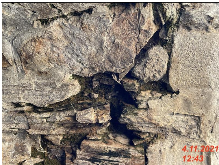
IMG_2186 - degradovana cast zdiva na podhledu NK vpravo cela prava cast je odrzena .jpg
