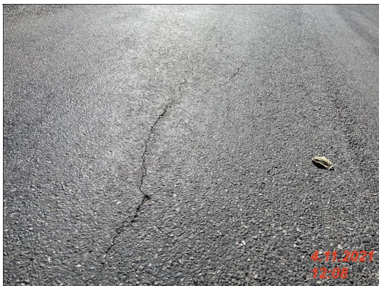
IMG_2074 - lokalni trhliny vozovky spise na konci objektu vpravo.jpg
