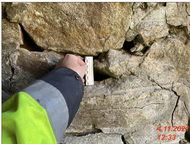
IMG_2156 - cela prava strana konstrukce opery i NK je odtrzena.jpg
