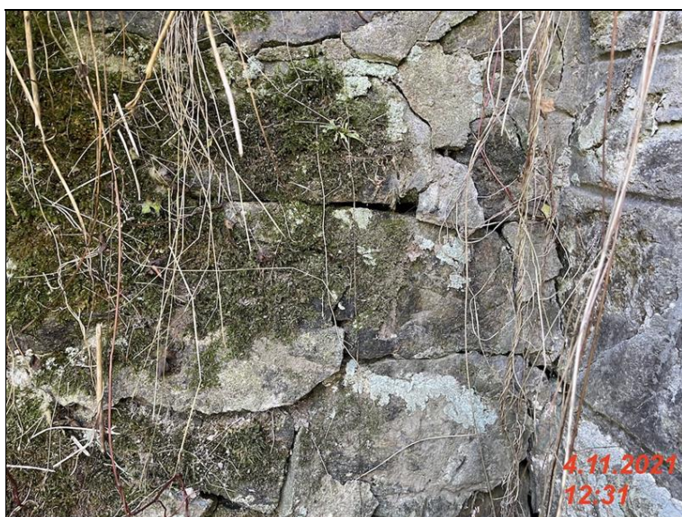
IMG_2145 - zdivo kridla K3 ma porusene sparovani zdivo je rozvolnene misty vysunute az o 50mm.jpg
