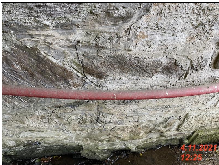
IMG_2123 - cca 700mm zleva je na opere O1 trhlina sire az 5mm.jpg
