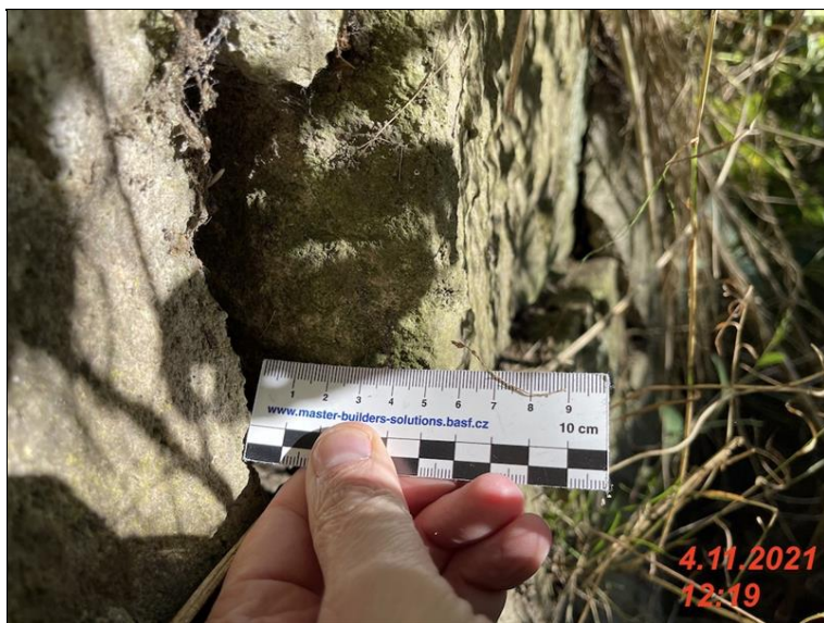
IMG_2112 - zdivo kridla K1 ma porusene sparovani zdivo je rozvolnene misty vysunute az o 50mm.jpg
