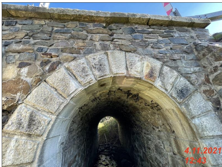
IMG_2187 - mirne otevrena cast zdiva v horni castli praveho cela v jeho 12 delky.jpg
