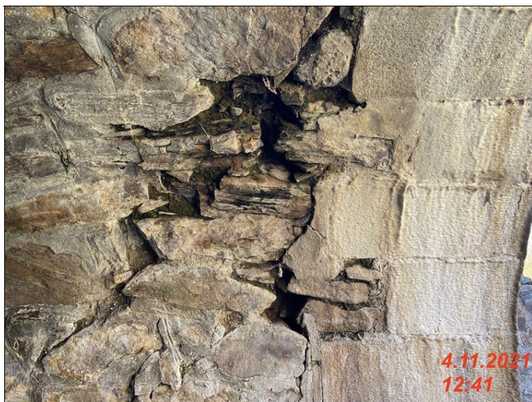
IMG_2182 - degradovana cast zdiva na podhledu NK vpravo cela prava cast je odrzena .jpg
