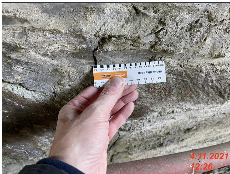
IMG_2127 - cca 700mm zleva je na opere O1 trhlina sire az 5mm.jpg
