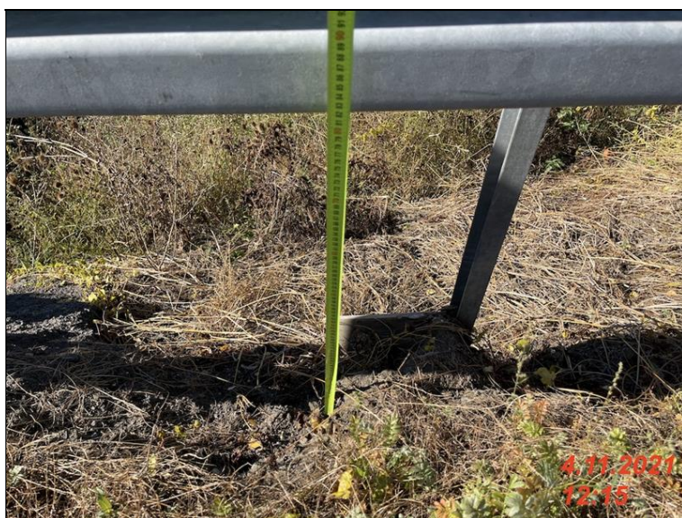
IMG_2095 - sirka krajnice na zacatku objektu vpravo a tím i vysokove osazeni svodidla 1150mm nesplnuji normove pozadavky.jpg
