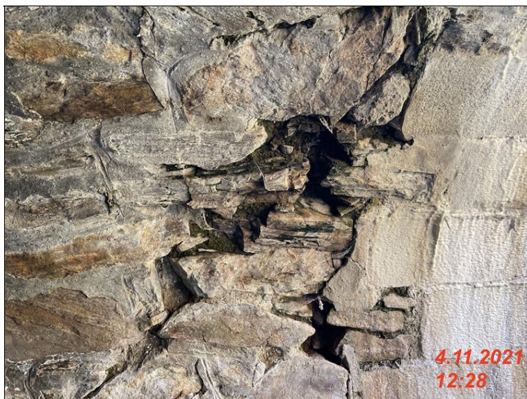
IMG_2134 - degradovana cast zdiva na podhledu NK vpravo cela prava cast je odrzena .jpg
