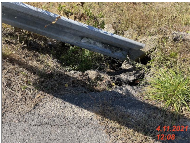
IMG_2065 - uvolnene kotveni pasnice na zacatku propustku vpravo na prepdoli.jpg
