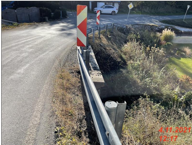
IMG_2107 - na rimsach by melo byt umisteno zabradelni svodidlo nebo zabradli svodidlo.jpg
