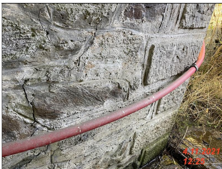
IMG_2126 - cca 700mm zleva je na opere O1 trhlina sire az 5mm.jpg
