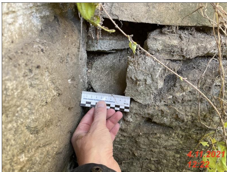
IMG_2115 - vypadla cast zdiva mezi levym celem a kridlem K1.jpg
