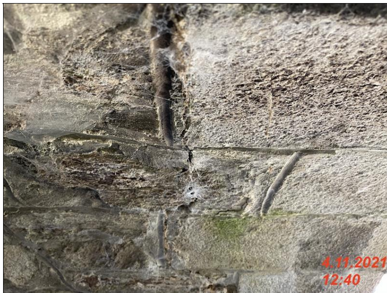
IMG_2171 - trlina cca 600mm od leveho okraje na podhledu nosne kostrukce sire cca 4mm.jpg
