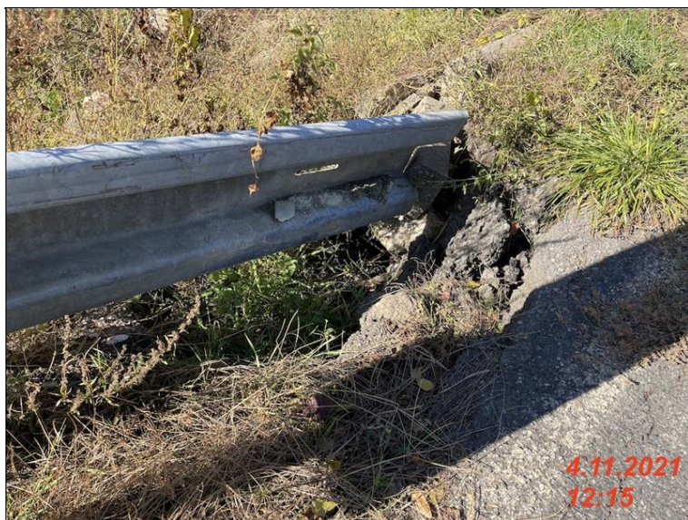
IMG_2097 - chybejici skluz na zacatku objektu vpravo.jpg
