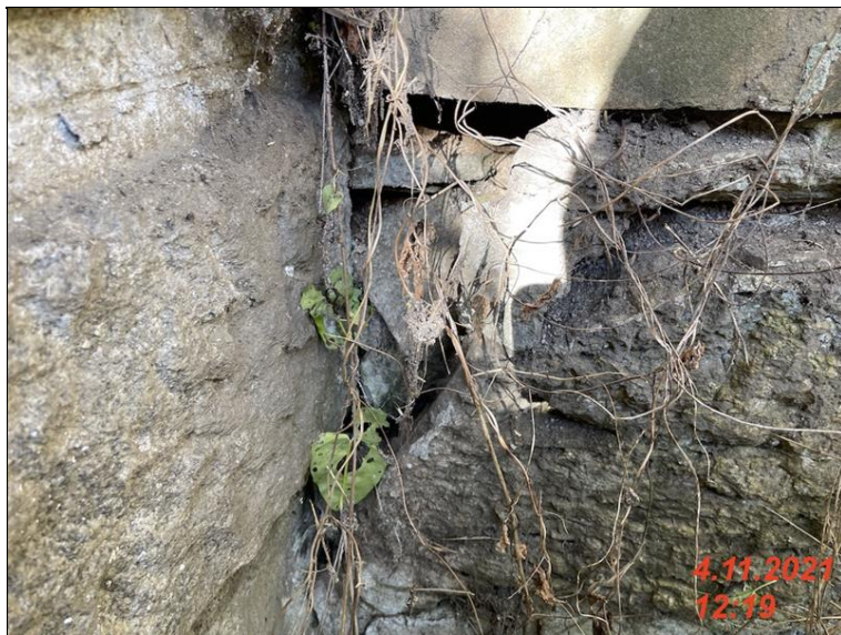
IMG_2114 - zdivo kridla K1 ma porusene sparovani zdivo je rozvolnene misty vysunute az o 50mm.jpg
